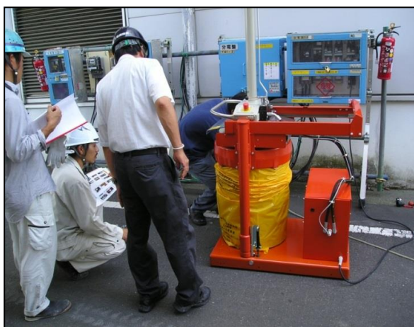
ドラムを上昇させドラムの外側にアスベスト指定袋をセット
